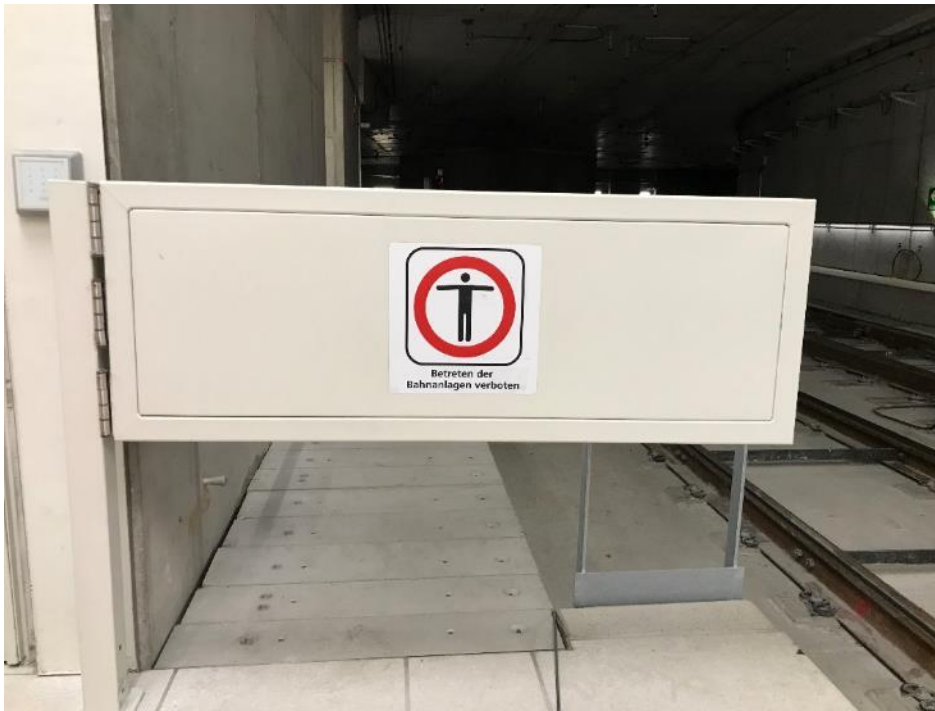
Abbildung 1: Sperrtor am Ende eines Bahnsteigs
